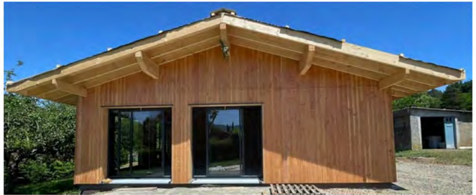
Menuiseries en PVC du Client
