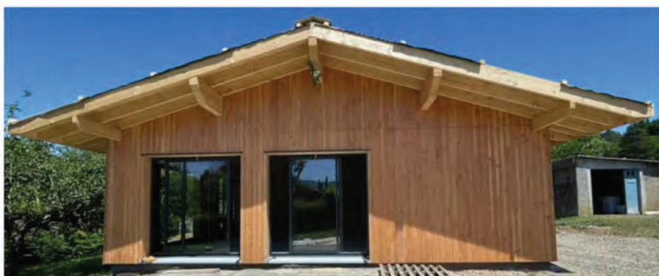
Menuiseries en PVC du Client
